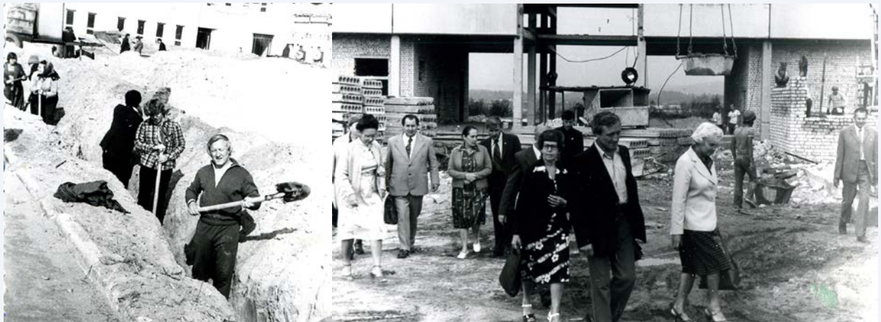
Будівництво технологічного корпусу ХФІ
