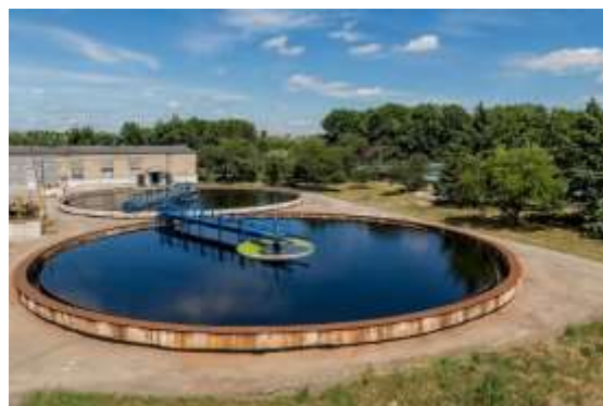
Рис. 1.4 – Приклад відстійників та аеротенків (первинні відстійники діаметром 40 м, глибина – 4 м, аеротенки з перемішуванням)
