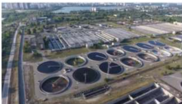
Рис. 1.4 – Приклад відстійників та аеротенків (первинні відстійники діаметром 40 м, глибина – 4 м, аеротенки з перемішуванням)
